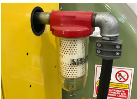
Il Filtro per carburanti ES-FILTER è uno dei modelli realizzati da Emiliana Serbatoi; compatibile per Gasolio, Benzina ed Etanolo, ES-FILTER è un filtro a cartuccia con contenitore trasparente ed elemento filtrante interno removibile.
